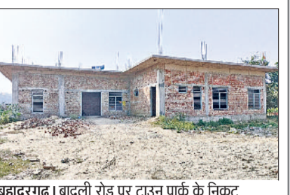
बहादुरगढ़। बादली रोड पर टाउन पार्क के निकट निर्माणाधीन रैन बसेरा।
