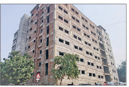
बहादुरगढ़। अस्पताल में अधूरा पड़ा नए भवन का निर्माण।
